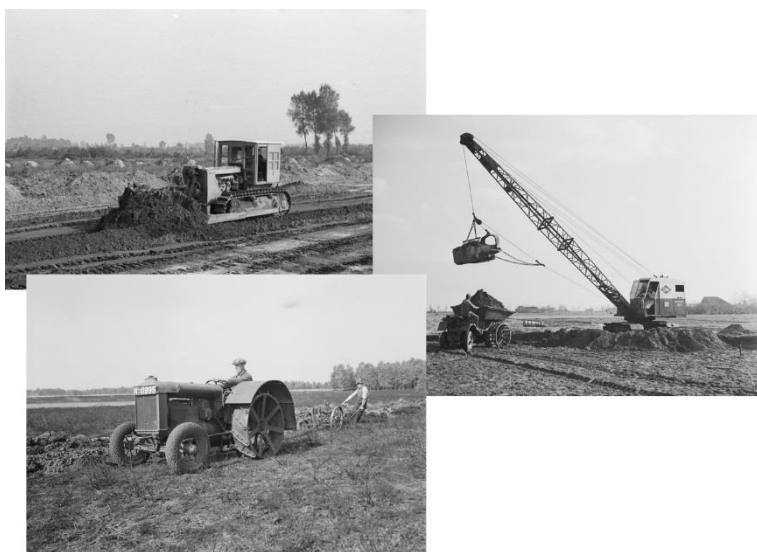
Ontginningswerkzaamheden in de jaren 50. Fotocollectie Nederlandse Heidemaatschappij
